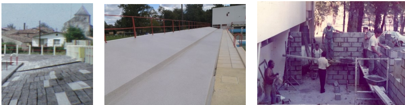
Les planches du solarium en bois et le nouveau solarium en béton construit en 1975 ; soubassements de la première cuisine, espace qui deviendra la « Salle des Clubs
