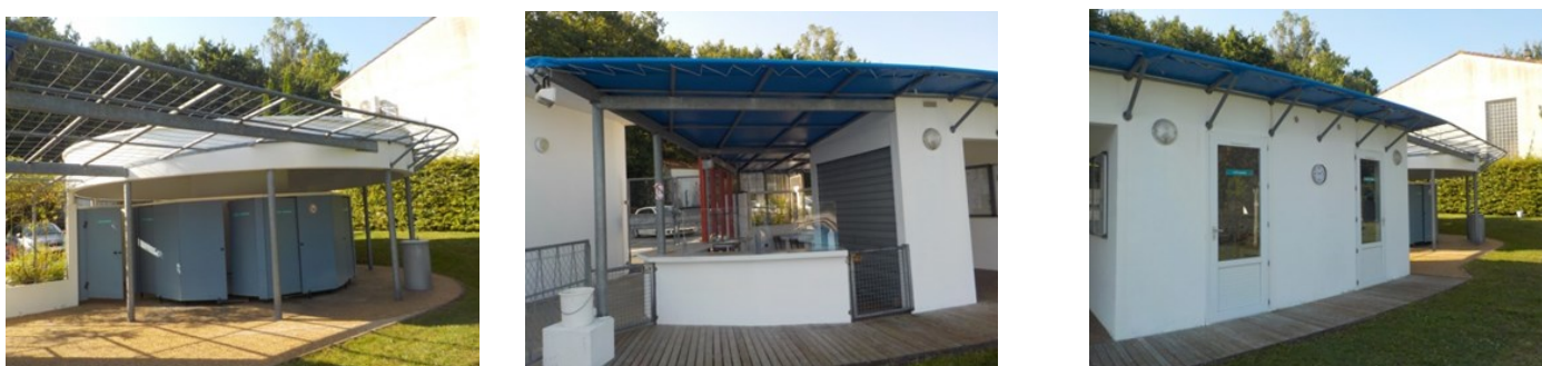
Les nouveaux locaux construits en l'an 2000 : sanitaires, bar, infirmerie et cabine du MNS
